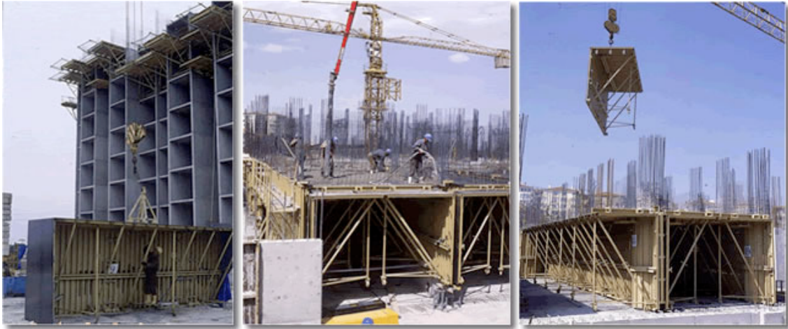
Şekil 1. Tünel kalıp ve yapım tekniği 1
